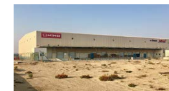
Depósito de piezas para el Medio Oriente y Cercano Oriente en los Emiratos Árabes Unidos
